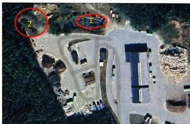
Figur 16 - Omlastningsanlegg - Kildal Miljøstasjon
